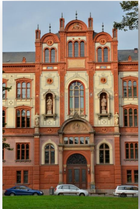
Abb. 5: Hauptgebäude der Universität Rostock
